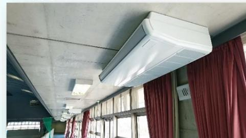
体育館北側に設置の大型エアコンでアリーナ床下に冷房・暖房された空気を送り込みます。2台設置することで1システムの故障時にも運転を継続することができます。
