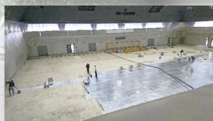
断熱シートをコンクリート面に敷きます。
